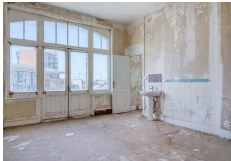
La société Conserto est à l'origine du projet de rénovation.
