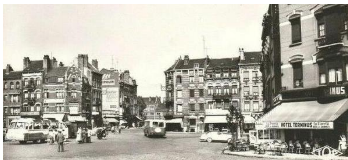
En face de la gare, l'hôtel Terminus est un lieu emblématique du quartier depuis plus d'un siècle. PHOTO REPRO « LA VOIX »
