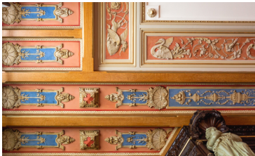
Plafond à caissons.
