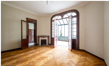
La double porte sur véranda est couronnée par une imposte de deux arcs surbaissés. Le parquet capture la lumière et oriente la pièce vers le jardin.
