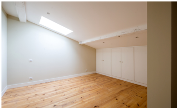
Les pannes de l'ancienne charpente sont intégrées dans l'aménagement des pièces sous combles.
