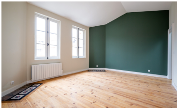
Au sol, conservation des seuils de cheminée.
